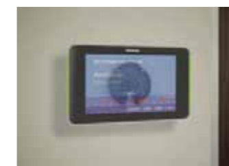
壁面(石膏ボード・メタルボード)
